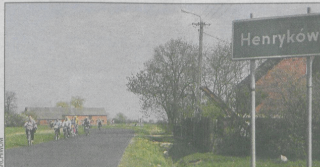
Ścieżka czeka na dalsze prace
