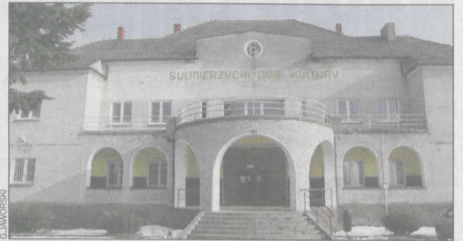
Dach może zostać naprawiony w tym roku
