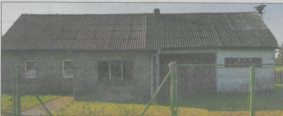
Stara świetlica zostanie zburzona
