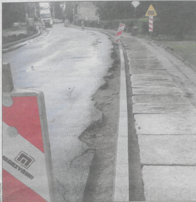
Trwają prace przy ul. Baszkowskiej
