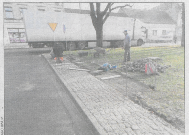
Na al. Powstańców prowadzone są końcowe prace, są już płytki przy trawie, a obok ławki
