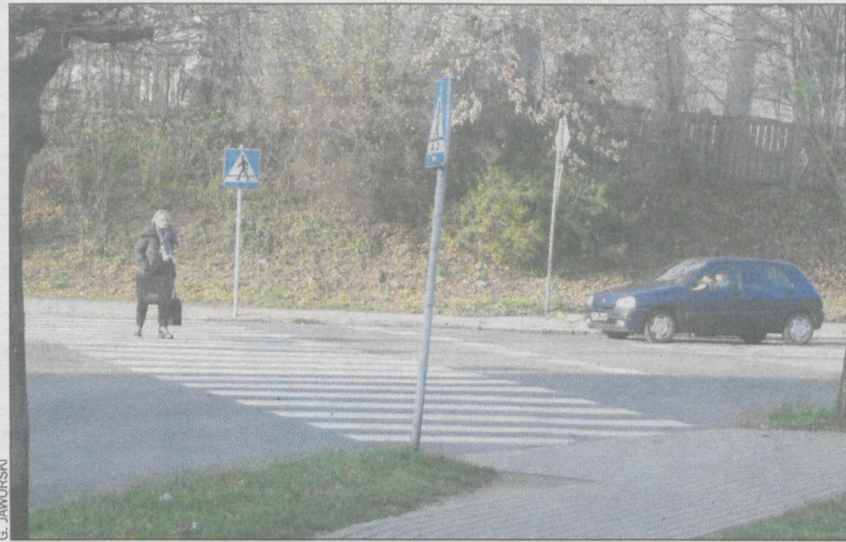
Przejście wieczorami jest nieoświetlone
