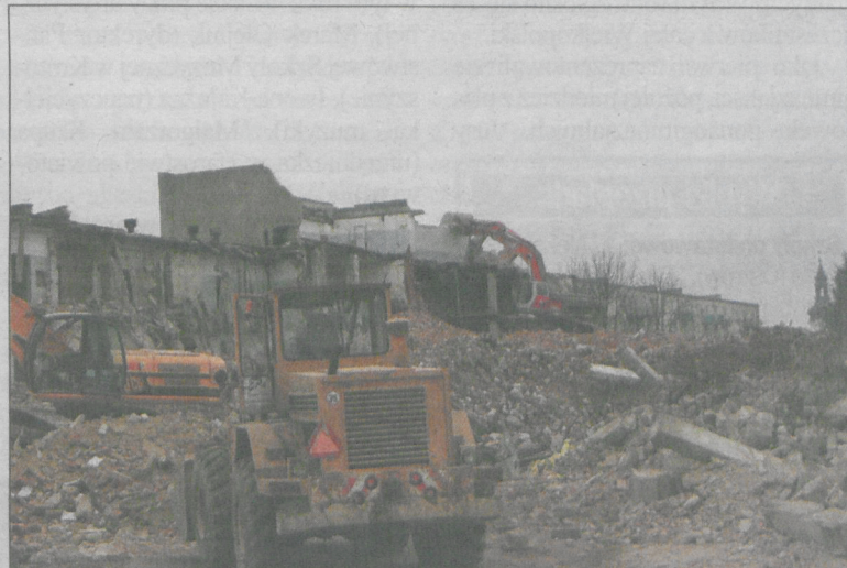
Prace rozbiórkowe to poważne przedsięwzięcia
