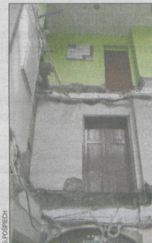
Prace w urzędzie trwają
