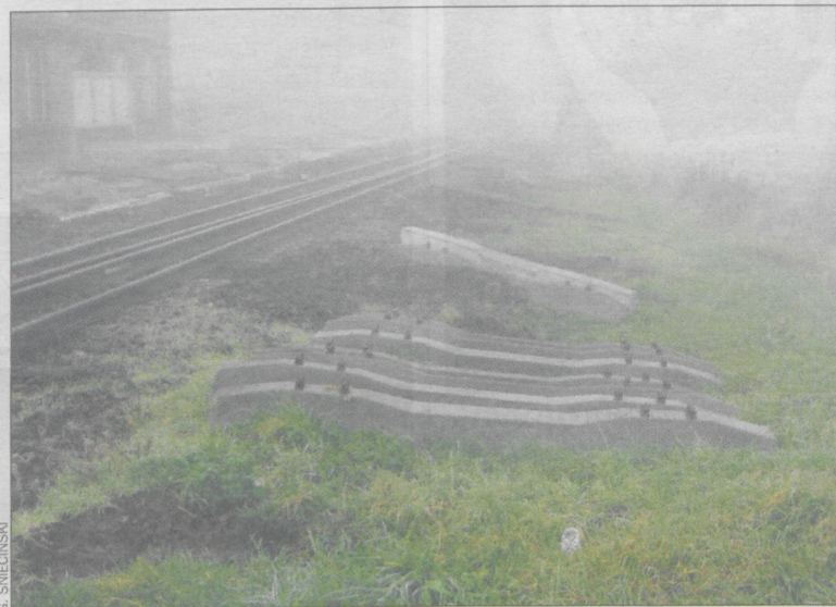
Nowe szyny i podkłady na stacji Cieszków
