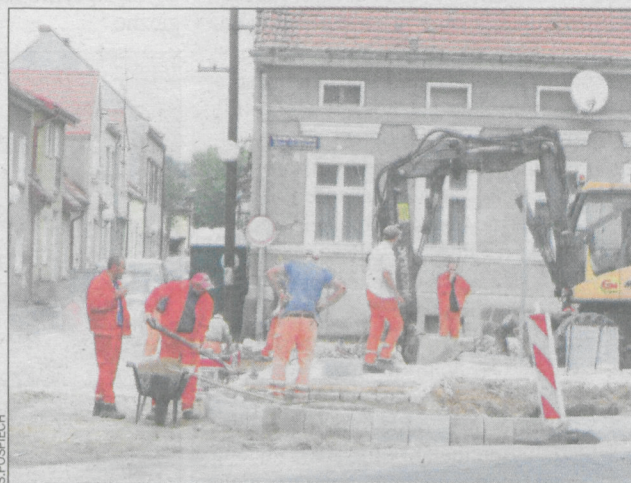
Rynek we wrześniu jeszcze w trakcie remontu
