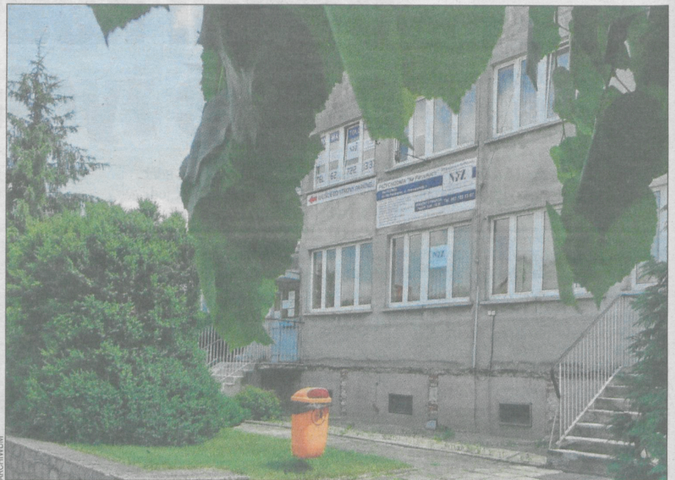
W przychodni powstanie winda, w budynku zostaną wymienione okna i drzwi
