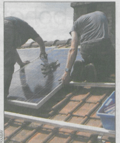
Panele solarne będą montowane
