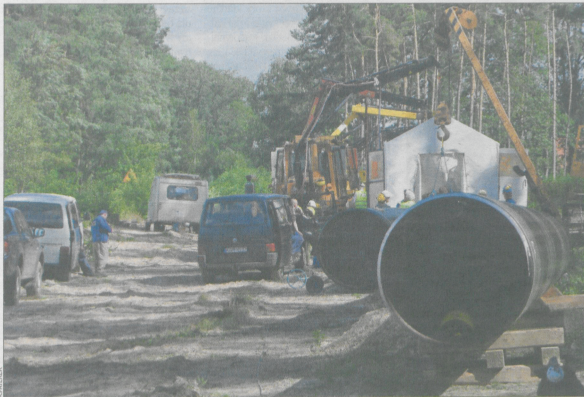
Przed wkopaniem rur w Chachalni
