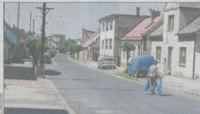
Kanalizacja będzie również na ul. Łacnowej
