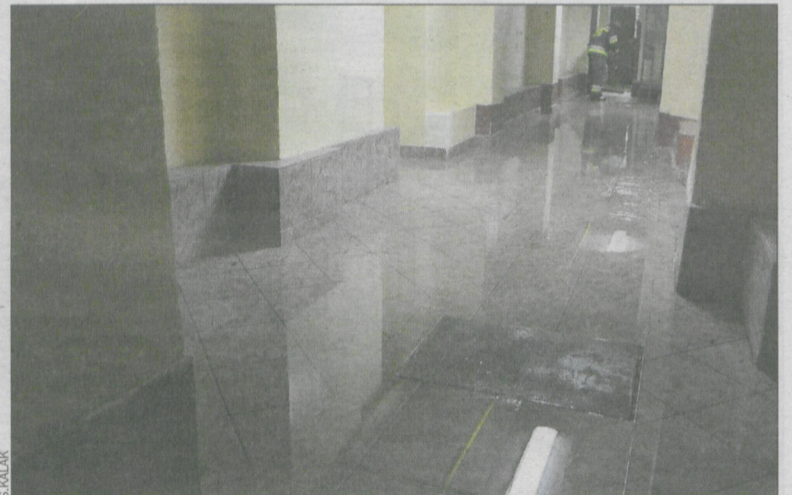
Awarię usuwali strażacy zawodowi i ochotnicy
