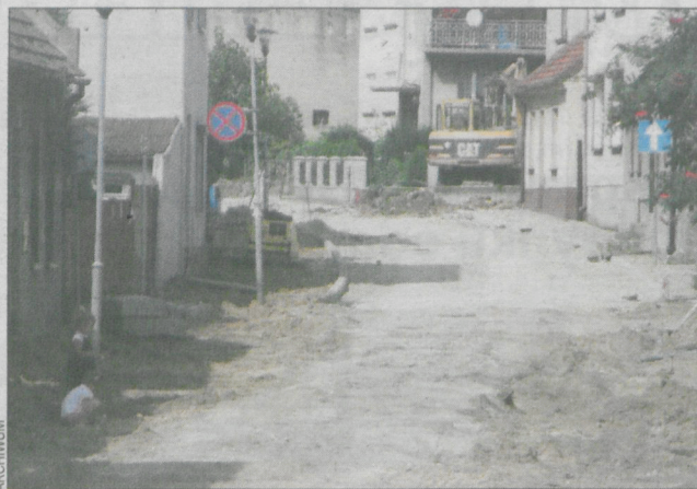
Remont drogi nie zakończy się w terminie
