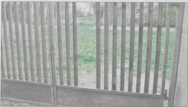
Boisko zostanie ogrodzone, powstanie też monitoring. W ub. roku pisaliśmy o dziurze w bramie, przez którą na teren ZSP2 przechodzą osoby i piją tam alkohol
