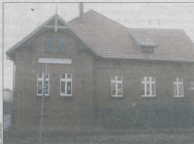
Przedszkole w Zdunach przejdzie całkowitą odnowę
