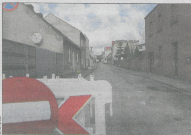
Remont drogi się opóźnia
