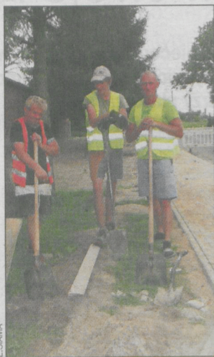
Remont wykonuje firma z Siedlca
