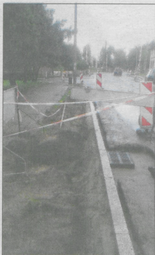
Trwa układanie krawężników
