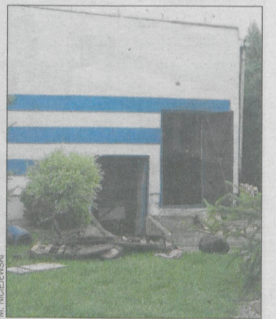
Kotłownia znajduje się na placu razem ze stacją paliw
