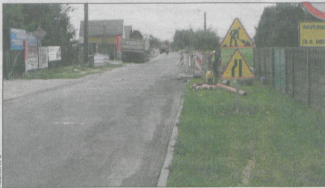
Ulica w czasie remontu
