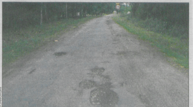
Takie zabezpieczenie zapobiegnie zniszczeniom na 5 lat
