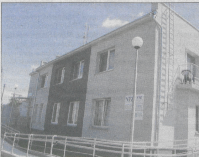
Budynek czeka na odwodnienie
