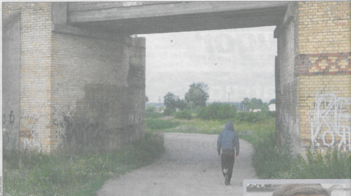
Do zdarzenia doszło w rejonie wiaduktu kolejowego na ul. Konarzewskiej
