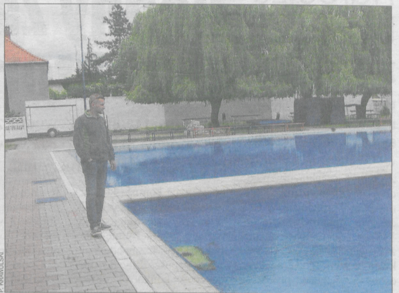
Obecnie na basenie trwają prace kosmetyczne
