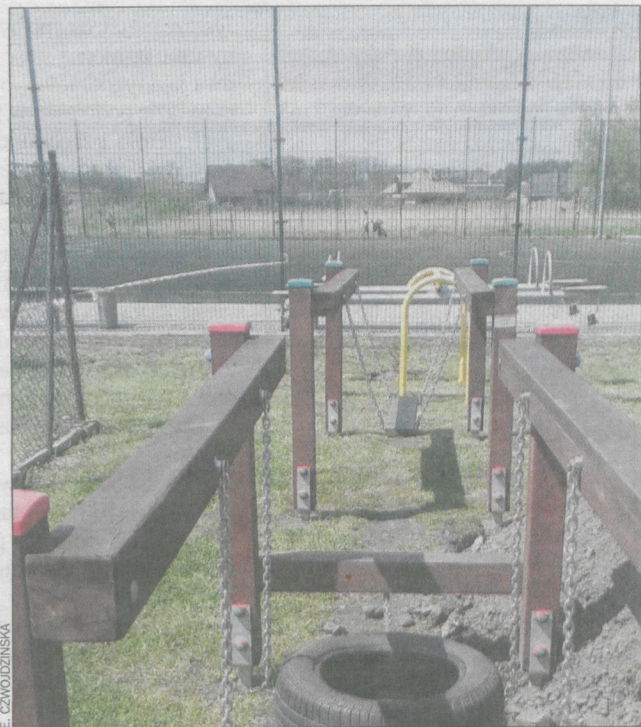
Prace wykonuje firma Pawła Bzdęgi
