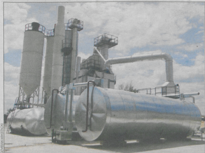
Serce zakładu to wytwórnia mas bitumicznych...
