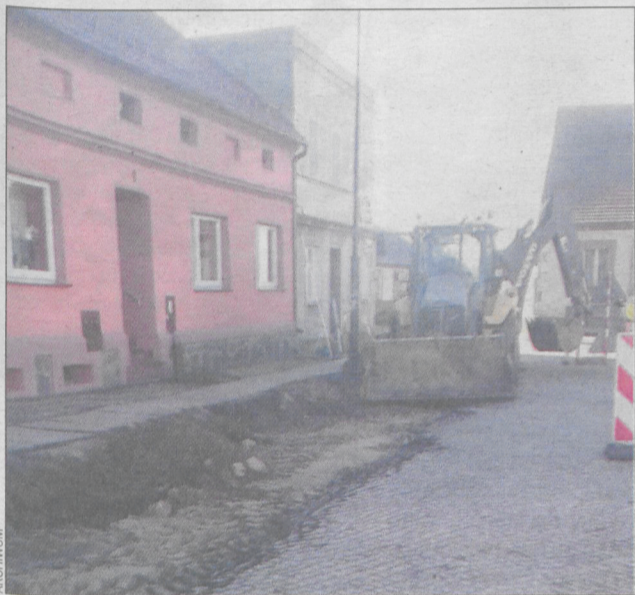
Zeszlaczony remont chodników na Rynku...
