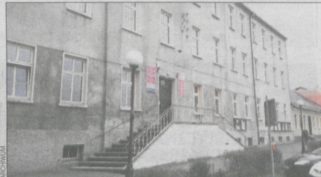
Urząd zyska nową elewację
