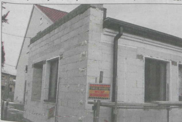
Prace budowlane już trwają
