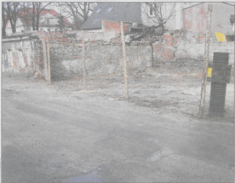
Ul. Poprzeczna jest w fatalnym stanie
