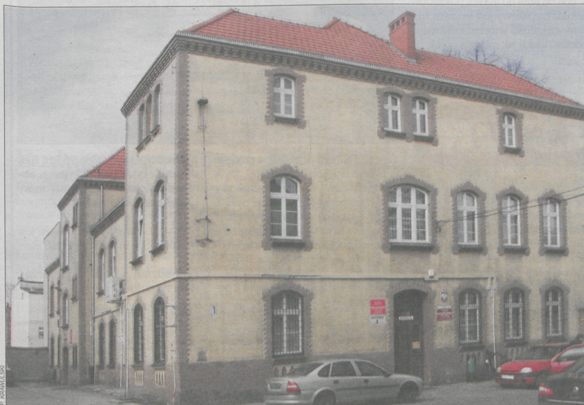
Czy budynek nr 1 zyska nową elewację?
