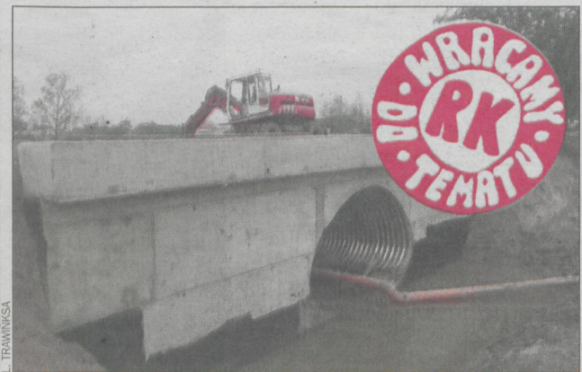
Most w trakcie prac
