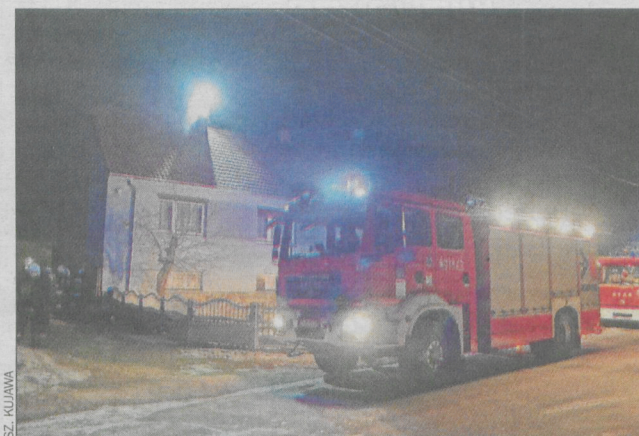
Komin na skutek pożaru popękał
