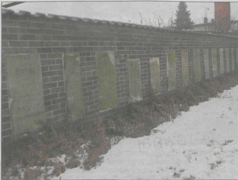
Kobylińskie lapidarium – macewy zostały umieszczone w murze
