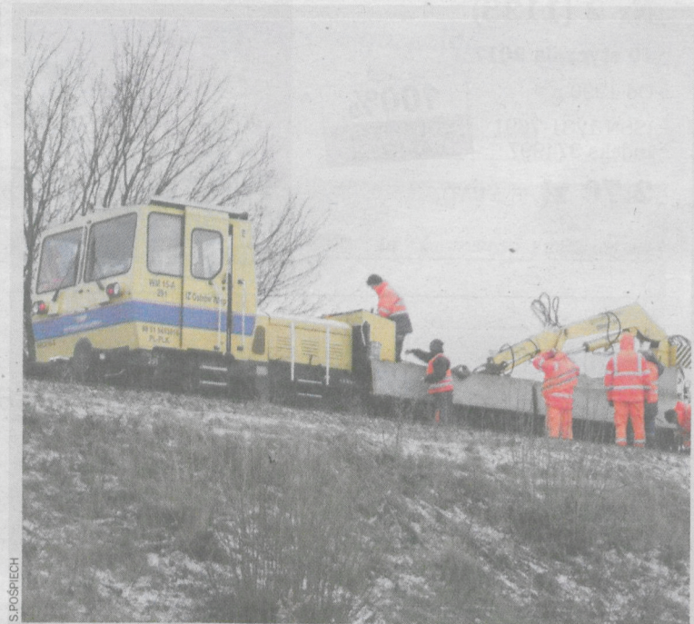
Remont wiaduktu. Wiadukt kolejowy na ul. Kobylińskiej w Krotoszynie (u zbiegu z ul. Wojciechowskiego) jest naprawiany. Ponoć jedno z przęseł zostało uszkodzone podczas przejazdu składu towarowego. (mac)
