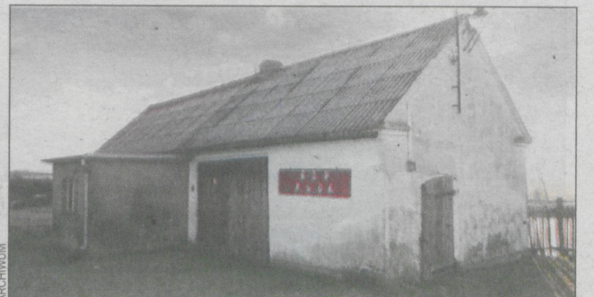
Stara świetlica jest w opłakanym stanie
