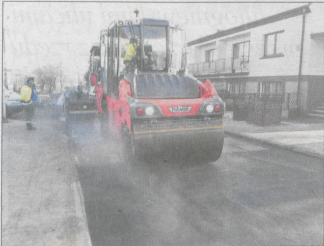
Był to I etap prowadzonej przez gminę inwestycji
