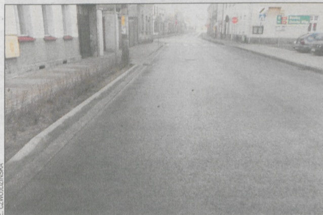
Nowa nawierzchnia na Alejach Powstańców Wlkp.
