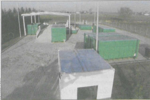
Powstała rampa, kontenery i oświetlenie terenu
