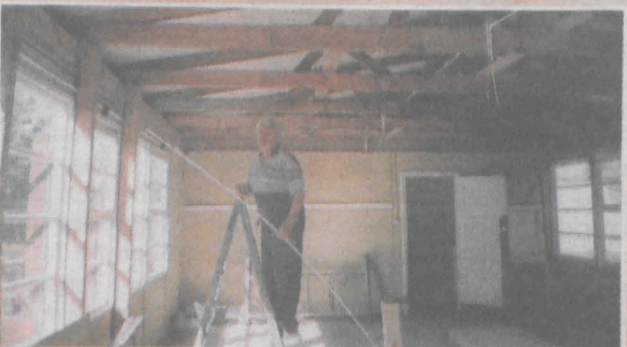
Remont świetlicy, rok 2003. Leon Tyrakowski zakłada elektrykę
