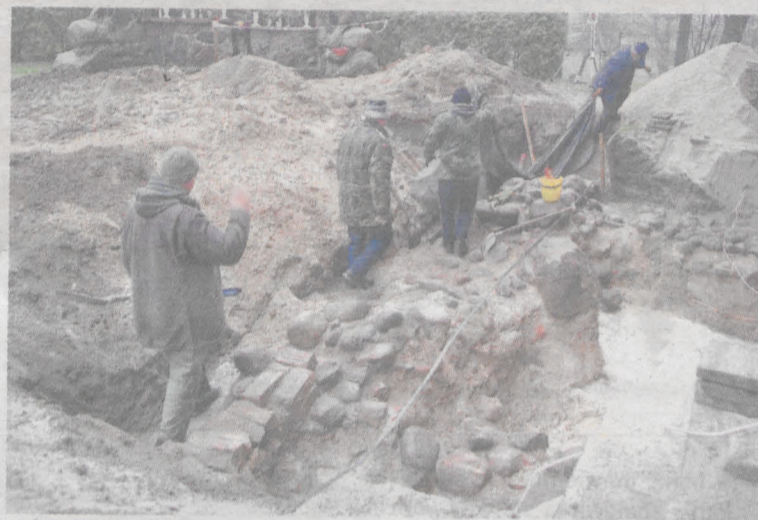
Prace wykopiskowe są prowadzone przy kościele w Nowym Mieście
