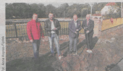
Prace przy realizacji pierwszego odcinka mają zostać wykonane do końca roku
