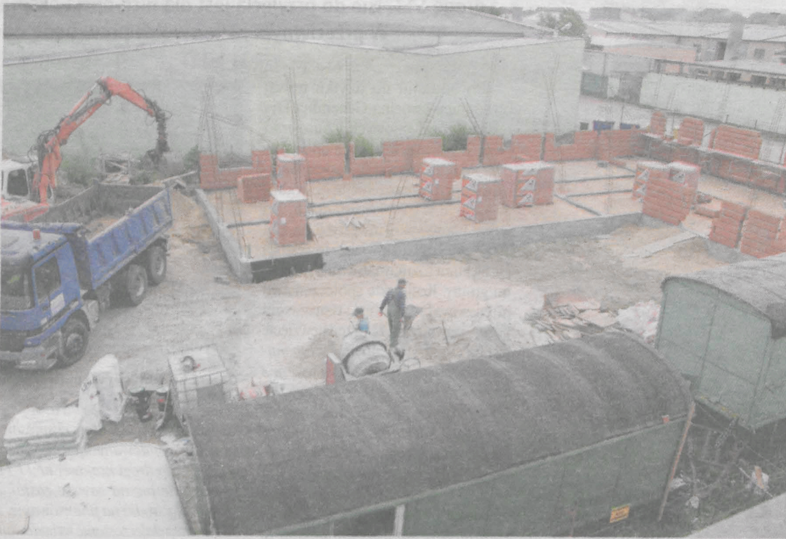
Prace przy rozbudowie mieszkań chronionych w Jarocinie rozpoczęły się w lipcu. Przewidywany termin ich zakończenia to sierpień przyszłego roku. Wykonawcą jest firma Hadrzyński z Kotlina. Dwukondygnacyjny budynek, który powstaje, będzie miał około 600 m 2 powierzchni
