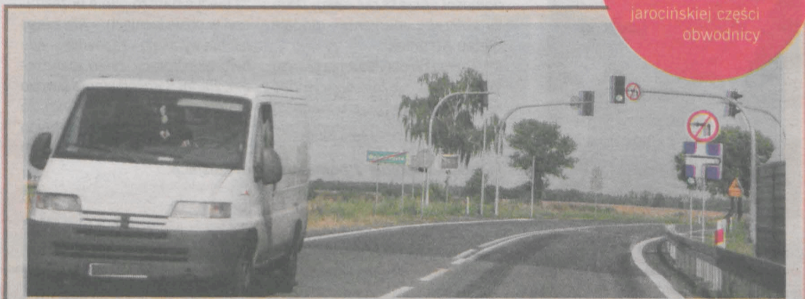
Sygnalizację świetlną zamontowano w lipcu tego roku. - Sygnalizacja świetlna jest efektem przeprowadzonego przez GDDKiA audytu bezpieczeństwa ruchu drogowego w ramach budowy obwodnicy Jarocina. Sygnalizacja jest akomodacyjna, co oznacza, że światło będzie się zmieniało, tylko wówczas, gdy
