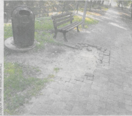
Brak kostki brukowej na ścieżce w Parku Szubianki
