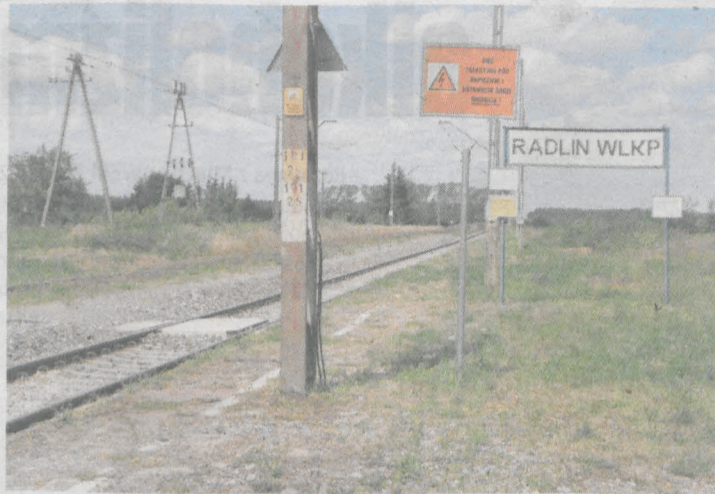
Na stacji kolejowej w Radlinie pasażerom najbardziej brakuje wiaty, w której mogliby się schronić przed deszczem i wiatrem
