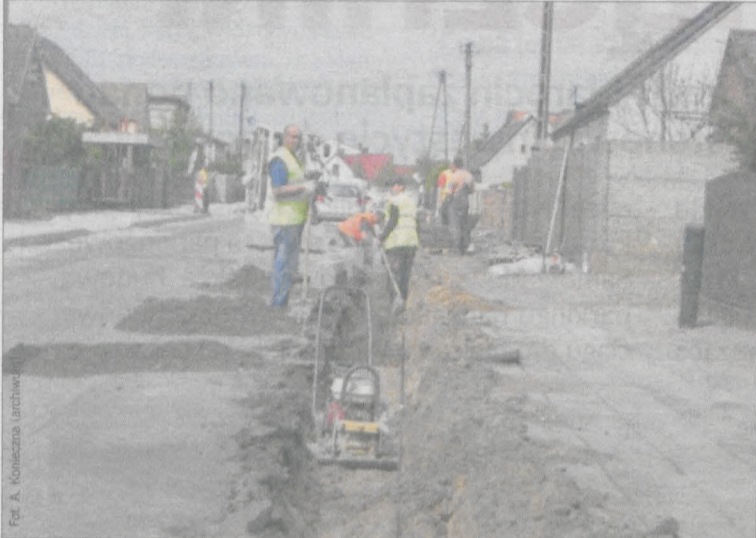
Droga powiatowa Jarocin - Żerków została przebudowana w latach 2009 - 2010. Wówczas była rozpatrywana również budowa ścieżki rowerowej. Ostatecznie jednak nie doszło do realizacji tej koncepcji
