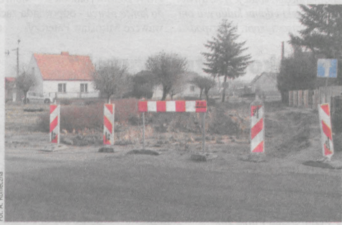
Przebudowa jednokierunkowego odcinka drogi przy szkole w Prusach jest w krótkim czasie drogą, gminną inwestycją wykonywaną w tej miejscowości. W ubiegłym roku gmina przebudowała również kilkudziesięciometrowy odcinek ślepej uliczki, gdzie oprócz nawierzchni z kostki brukowej, zamontowane zostało nowoczesne oświetlenie typu LED
