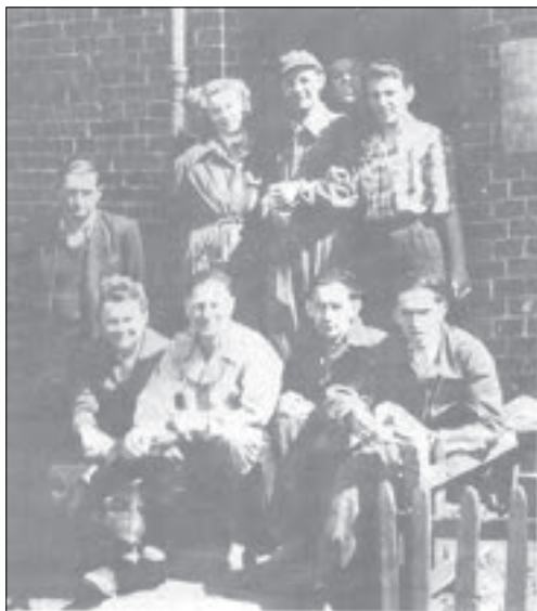
Administracja Zakładu Przemysłu Terenowego Materiałów Budowlanych w niedzielę pracuje społecznie w cegielni w Miękini.
