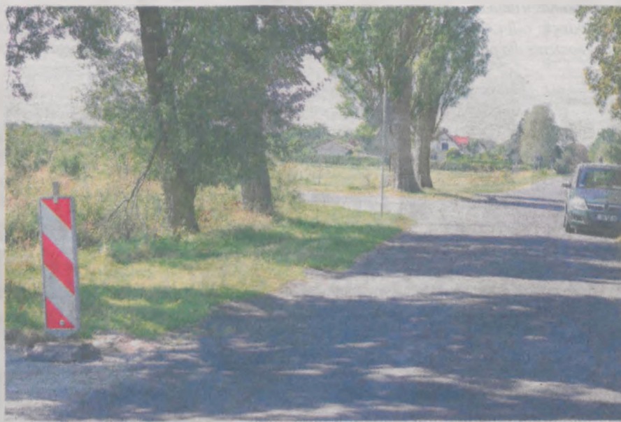
Odcinek od znaku (z lewej strony) do skrzyżowania należy do powiatu i zostanie wyremontowany razem z drogą Góra - Nosków w 2018
