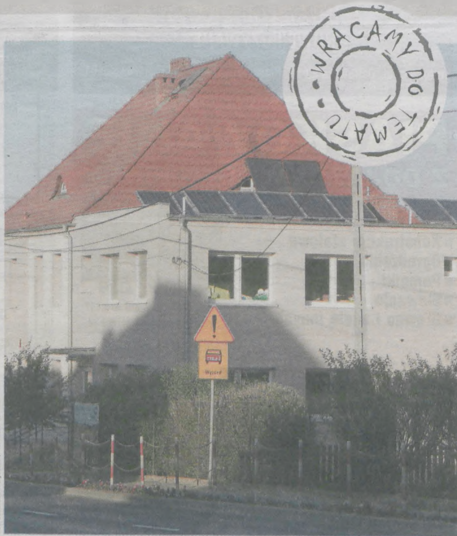
W ramach poprzedniego dofinansowania systemy fotowoltaiczne zostały zamontowane m.in. na budynkach użyteczności publicznej. Na zdjęciu przedszkole w Jaraczewie
