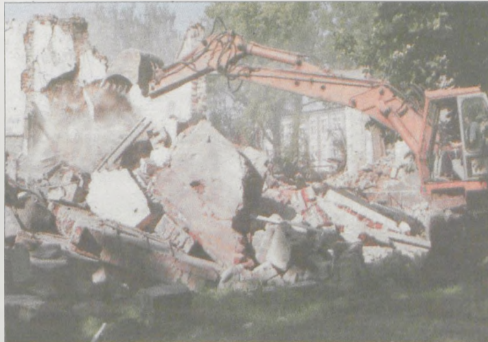
Ochronka w trakcie rozbiórki...
