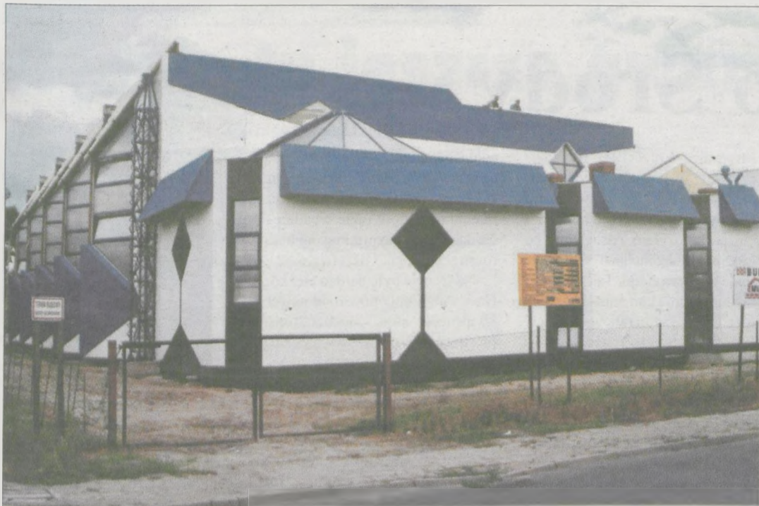
Pływalnia z zewnątrz jest już prawie gotowa. Główne wejście na basen znajduje się obok sali sportowej Zespołu Szkół Zawodowych. Tam też znajduje się winda dla wózków inwalidzkich.
