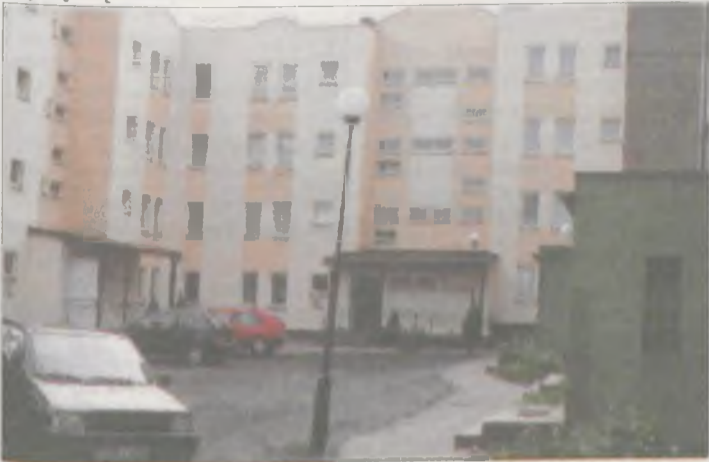
Sygnaly o niszczeniu klutek schodowych pojawiły się w zasadzie już dzień po oddaniu bloku do użytku. Problem wówczas
