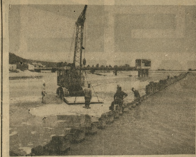
Budowa drugiego ujęcia wody dla Śląska, która będzie dostarczana z Soli.
