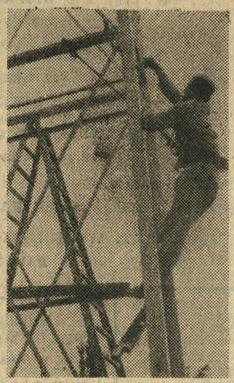
Na terenach targowych coraz więcej ekspozycji, coraz więcej dźwigów wydobywających ciężki sprzęt i skrzynie z towarami. Równocześnie w szeregu hal i pawilonów dobiegają końca prace przygotowawcze. Na zdjęciu - ostatnie pociągnięcia pędzlem i... stoisko można uznać za przygotowane.
