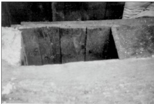
Wejście do schronu w piwnicy znajdujące się w szerokim parapecie okna. Źródło: Raport Katzmanna , str. 55. Wyd. IPN. Warszawa 2001
