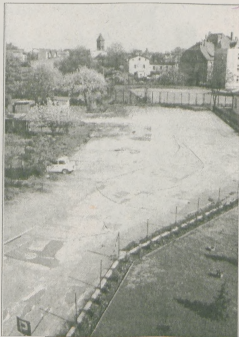
Na zdjęciu widok remontowanego placu z okien naszej redakcji.
