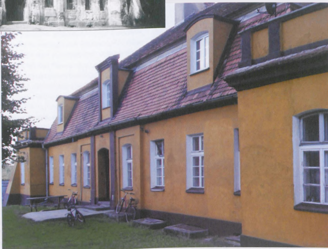
Dwór obecnie (poniżej) oraz przed remontem w latach 70. XX wieku
