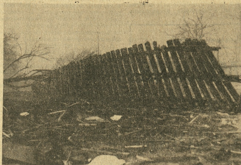
To nie plot, lecz wyrwany detonacją bomby tor na rozjeździe.
