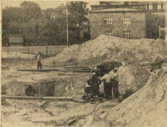
Godz. 11 — budowa wiaduktu górczyńskiego. Setki samochodów tłoczą się na wąskich objazdach (ważny szlak komunikacyjny południe — północ) a tymczasem tempo robót nie jest i tu oszalać.
