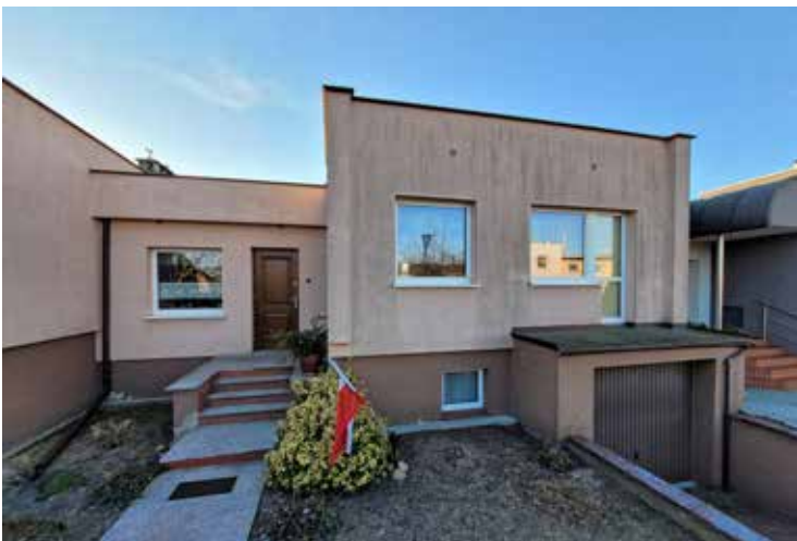
Dom zbudowany w 1982 roku po 40 latach eksploatacji został gruntownie wyremontowany
