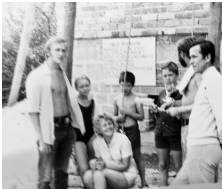
Budowa domu na Miśnieńskiej nabierała tempa – „wizytacja” w 1972 roku; Wojtek, Kasia, Piotr Czubiński, Karol, (zapewne) STS i główny budowniczy, w centrum Miroslawa
