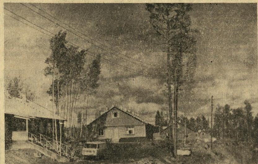
Na Angarze, 250 km poniżej Bracki, w miejscowości Ustje-Lima powstaje elektrownia wodna nie mniejsza niż Bratska GES. Na zdjęciu: domki budowniczych.
